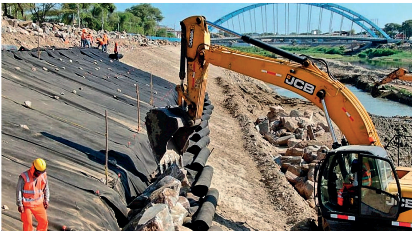
Imagen 13. Obras de reconstrucción en Piura
