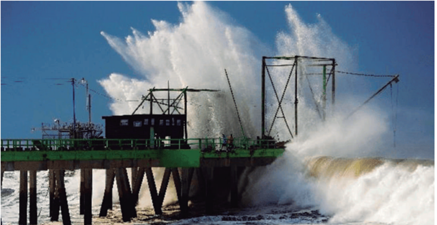
Imagen 17. Afectación de infraestructura pública en Panamá
