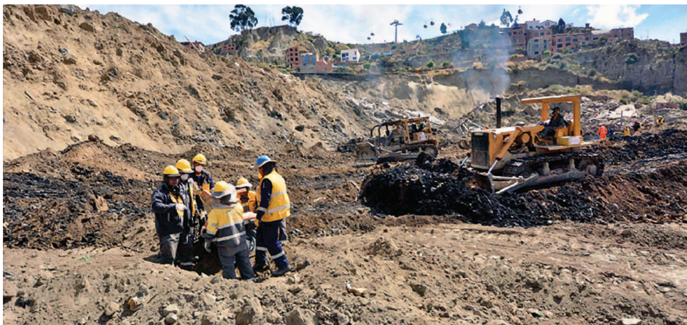
Imagen 1. Obras de reducción del riesgo de deslizamientos en La Paz
