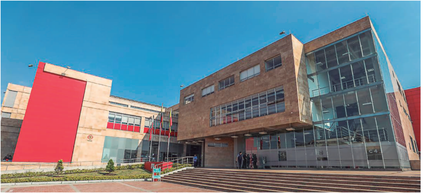
Imagen 7. Reforzamiento Centro de Comando de Bomberos y construcción del Comando, Control, Comunicaciones y Computo C4 de Bogotá Fuente: Secretaría de Seguridad, Convivencia y Justicia. Recuperado de: https://scj.gov.co/es/emergencias/centro-comando-control-comunicaciones-y-c%C3%B3mputo-c4
