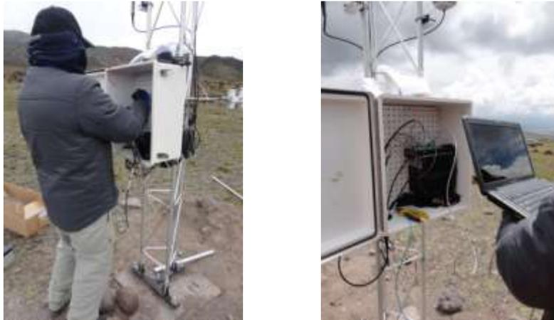
**Figura 3.14** Instalación Datalogger Campbell
