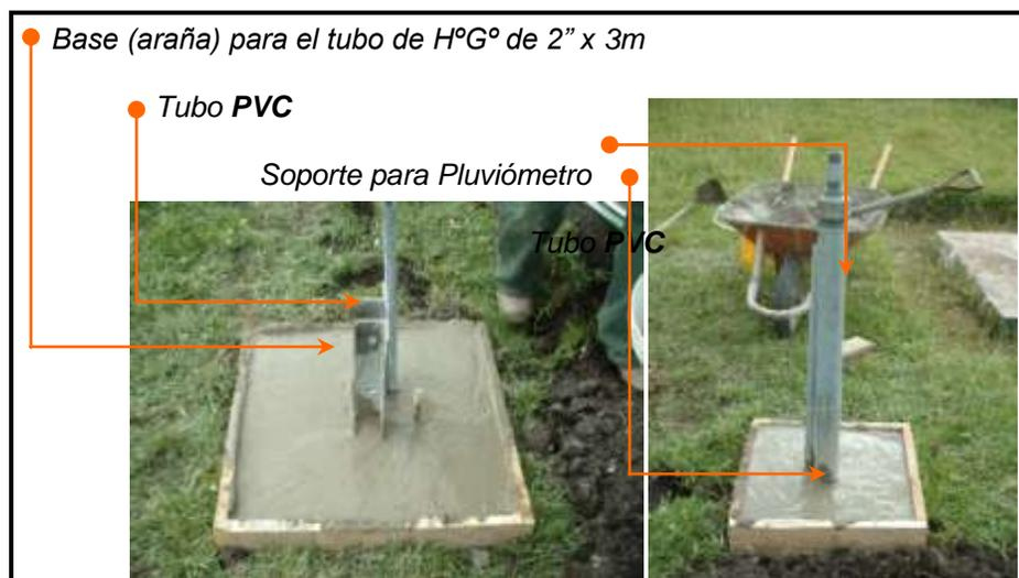
**Figura 4** Soportes Instalados
