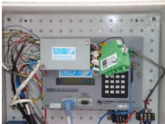
**Figura 1.12** Vista del Datalogger instalado en la Estación ORE
