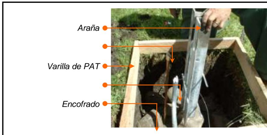
**Figura 3** Fundición de Base de Soporte para Estación
