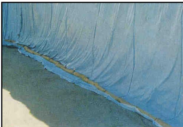
forma plana sobre el piso para permitir un adecuado sellado y evitar fugas de gas.
