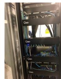
Adicionalmente se han reemplazado los switches que presentaban fallas por unos con prestaciones POE (Power Over Ethernet), que permiten utilizar los teléfonos sin adaptadores de energía) y se ha reordenado todo el cableado.
