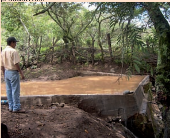
Foto 3: Obras de captación del recurso agua. Fuente: Municipio de Paltas.
