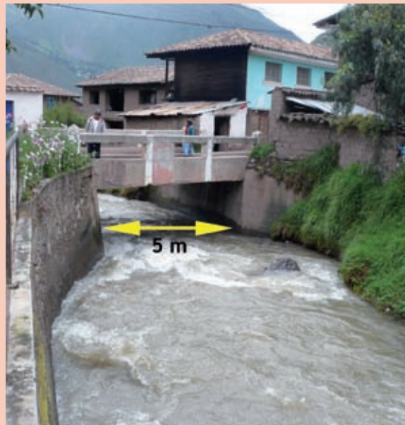
Foto 2: Estrechamiento del río Cochoc a la altura del puente Inclán. Fuente: PREDES.
