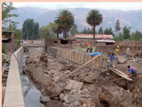
Foto 8: Obra demostrativa de ampliación del cauce del río Quchuq en el sector Piste. Fuente: PREDES.
