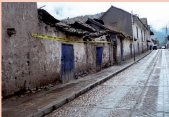
Foto 3: Viviendas en mal estado en la Ciudad de Calca. Fuente: PREDES.
