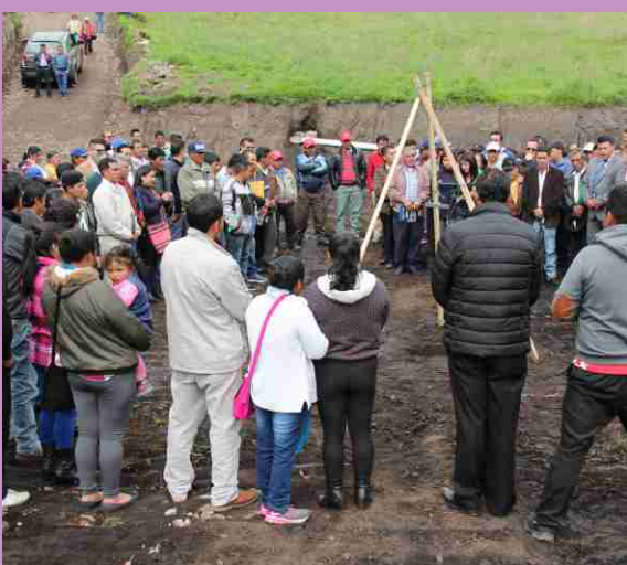
Inicio de construcción de planta de tratamiento de agua residual
