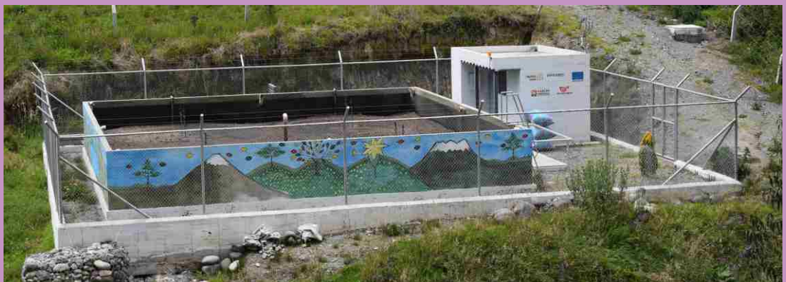
Planta de tratamiento de aguas residuales ecológica
